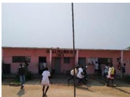
Figura 100 – Vista geral da escola primária BG 1056 (bairro Taca)
