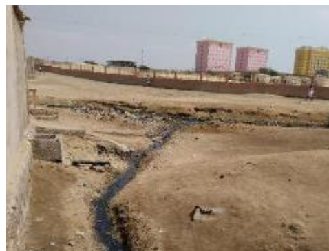
Figura 119 – Descarga directa em vala aberta (bairro Dokota)
