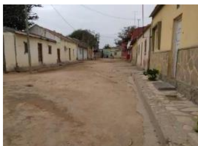
Figura 90 — Vista geral de assentamentos no bairro da Camunda
