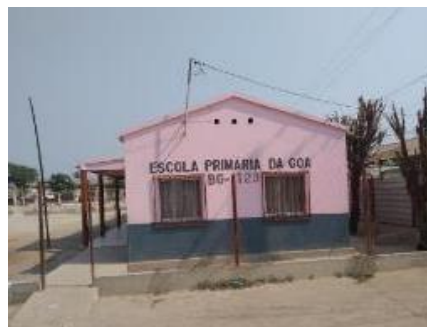
Figura 99 – Vista geral da escola primária Goa (bairro Goa)
