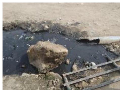
Figura 117 – Pormenor de descarga directa em vala aberta (bairro Calundo)
