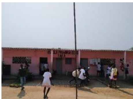
Figura 102 – Vista geral da escola primária BG 1056 (bairro Taca)
