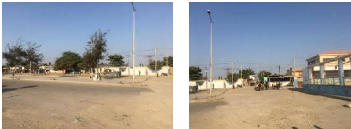
Figura 164 – Vista da Marginal de Benguela, onde ocorrem inunda es no Bairro de Goa
