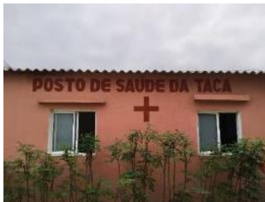
Figura 109 – Vista geral do Posto de Saúde da Taca (bairro da Taca)
