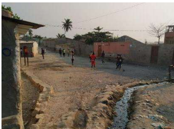
Águas residuais na via pública em zona residencial (bairro São João)
