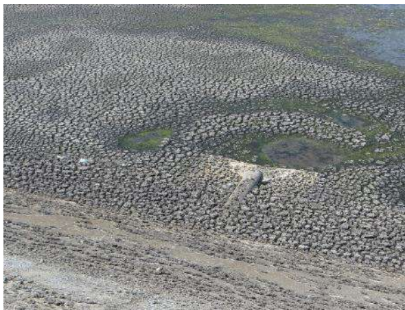
Pormenor da tubagem para esvaziamento do sobrenadante da lagoa facultativa primária
