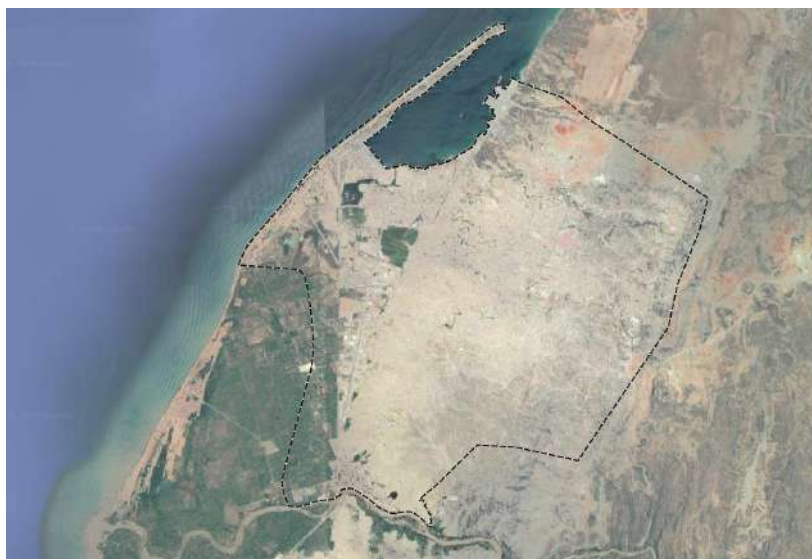
Figura 1.1 – Área de intervenção da cidade do Lobito
