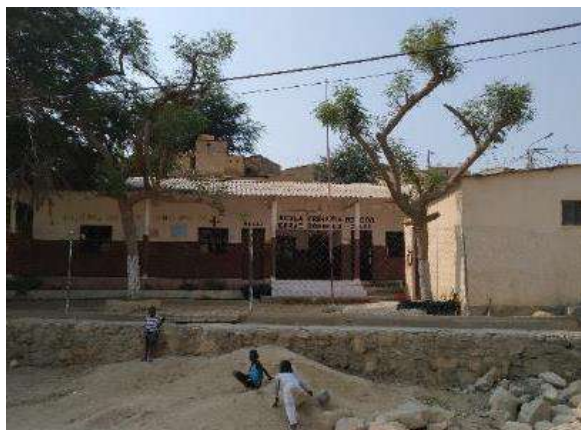
Vista geral da escola primária Ferraz Bomboco (bairro Chiule, Catumbela)
