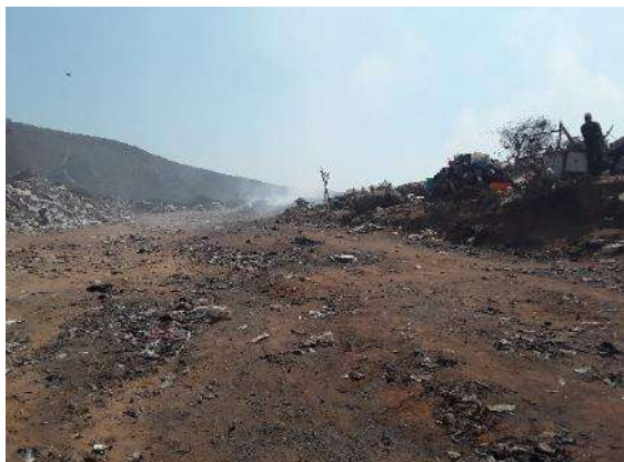
Vista geral do local de deposição final de resíduos sólidos em Lobito (vista 1)
