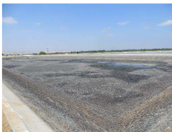
Vista geral de lagoa facultativa primária (na fase de secagem das lamas para posterior remoção)
