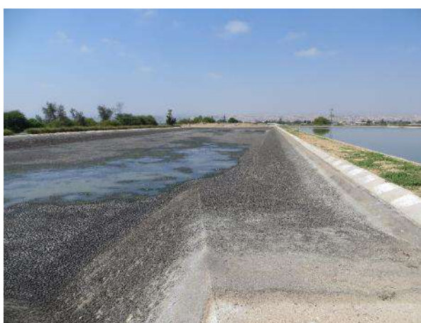
Pormenor da rampa existente na facultativa primária para facilitar a remoção das lamas
