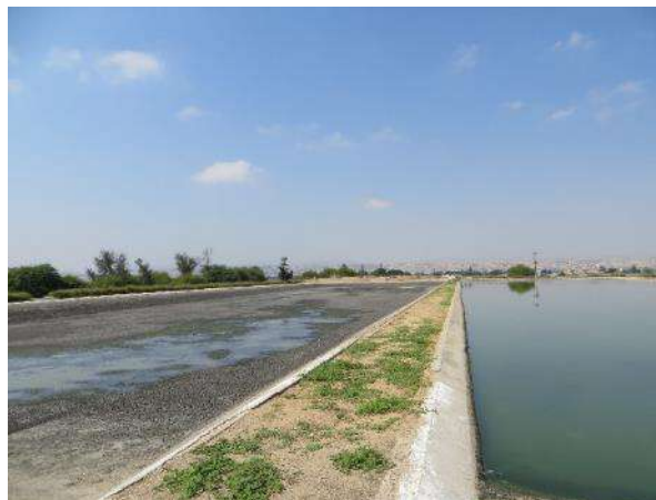
Lagoas facultativas primárias (à esquerda em processo de secagem de lamas, à direita em funcionamento)
