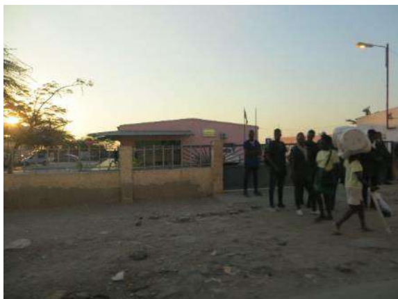
Vista geral do Instituto Politécnico Martins Ferreira (bairro Bela Vista Alta, Lobito)
