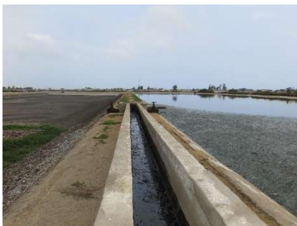
Câmara de repartição de caudal às lagoas facultativas (à esquerda, lagoa primária após remoção de lamas)
