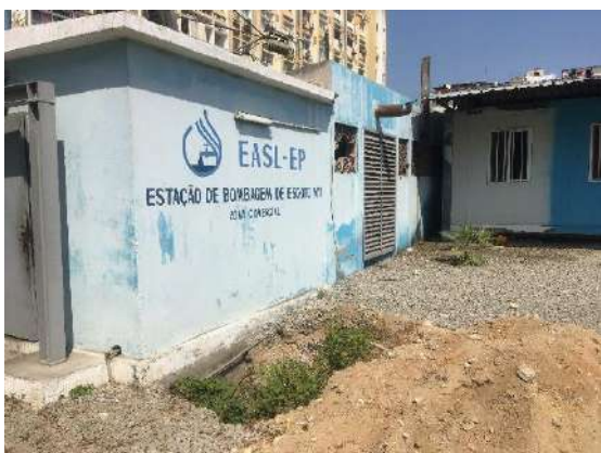
Visita à Estação Elevatória 1
