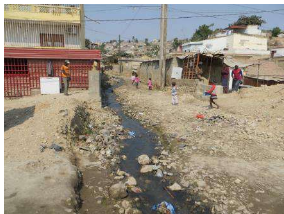
Águas residuais na via pública em zona residencial (bairro Africano / Chivili)
