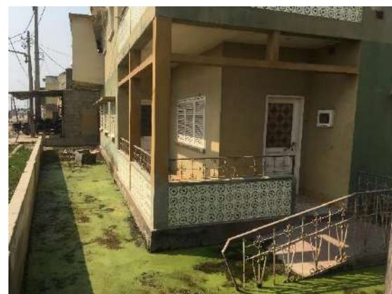
Vista geral de habitação em zona com nível freático muito elevado (vista 4, bairro de São João)
