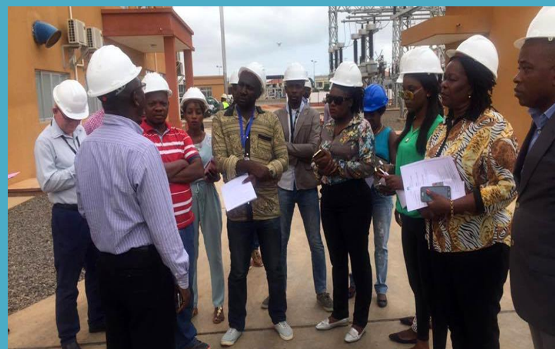
Visita dos jornalistas e fazedores de opinião as novas infra-estruturas eléctricas (Subestação do Morro Bento e Morro da Luz).
