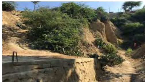
Arruamento para o traçado entre os pontos 16 e 17
