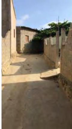
Arruamento para o traçado entre os pontos 12 e 13
