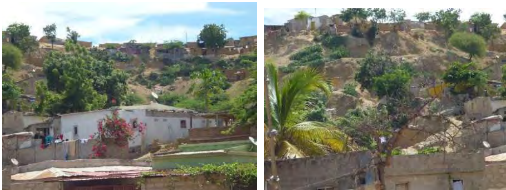
Fotografia 6.2 – Encostas habitadas no bairro de Bumba
