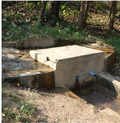
Figura 33 – Mina de água de Cambondo
