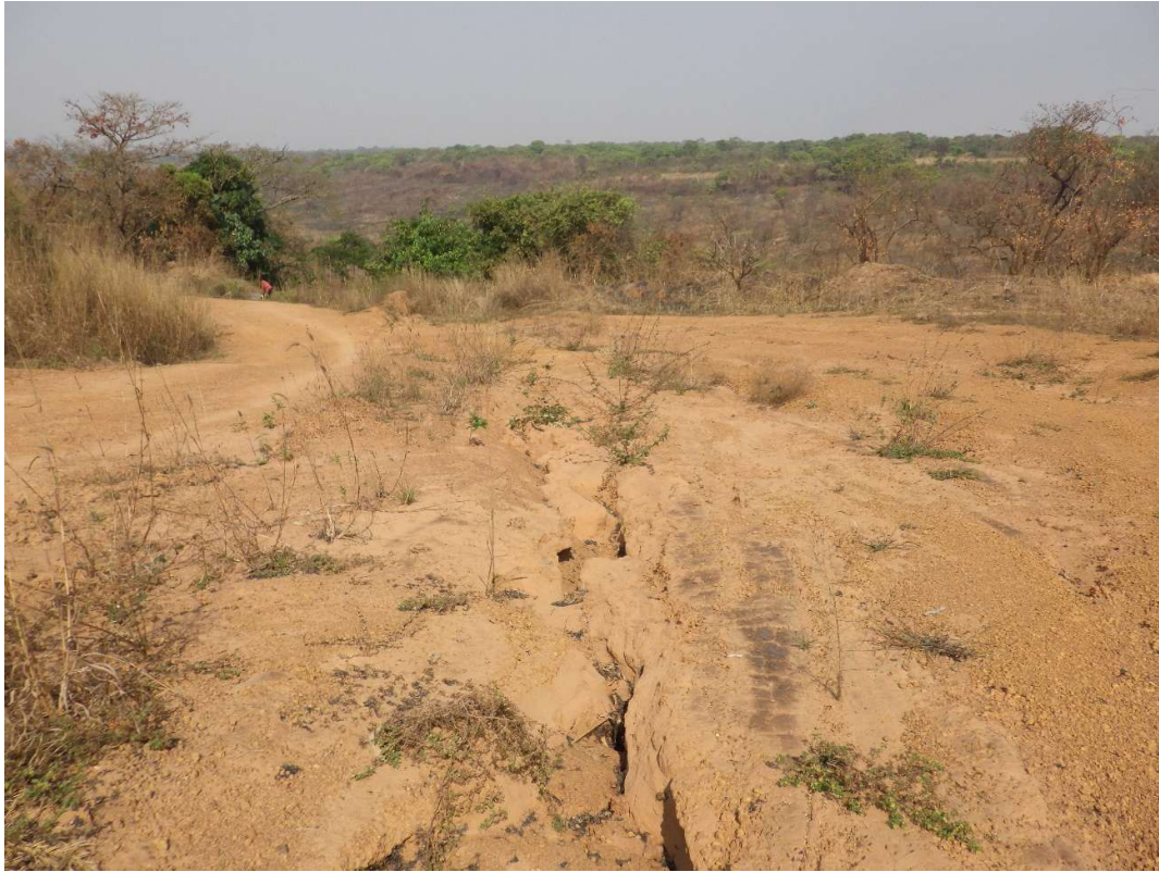
Figura 53 – Erosão em sulcos ao longo de uma estrada não pavimentada (Cambondo, Malanje)
